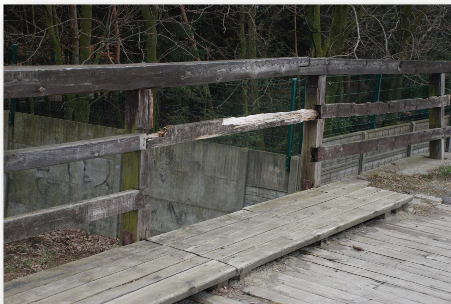
19. Widok od spodu na belkę skrajną. Korozja drewna pokładu dolnego. Korozja dźwigarów stalowych.
