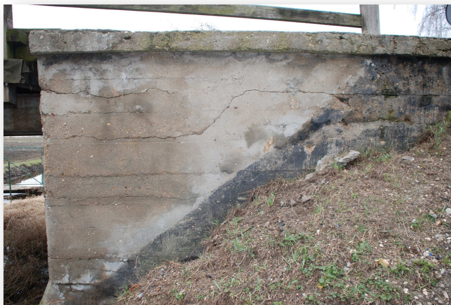
11. Widok z boku na skrzydło. Widoczne spękania, ubytki oraz korozja betonu.
