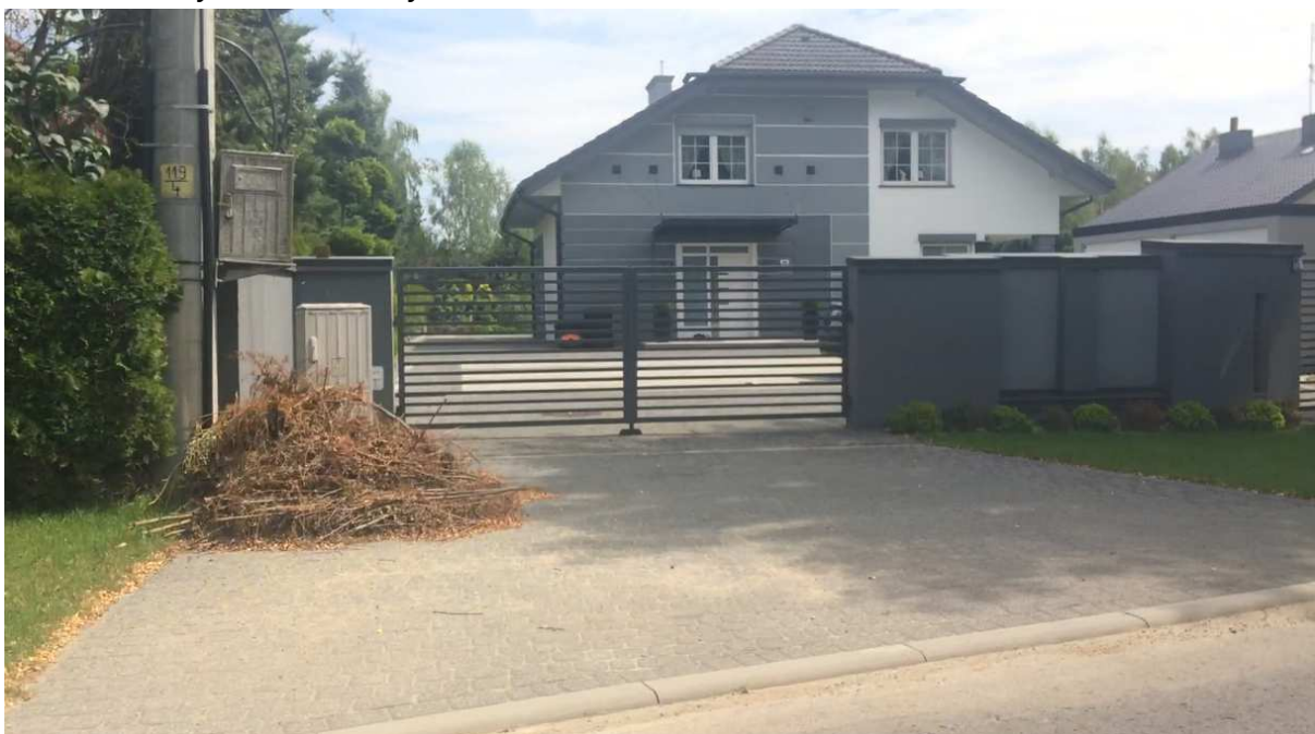
153. numer ewidencyjny działki 658/3 na działce budynek mieszkalny – dom nr 4f
