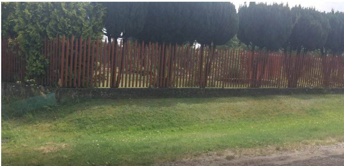
125. numer ewidencyjny działki 304/2 na działce budynek mieszkalny – dom nr 54
