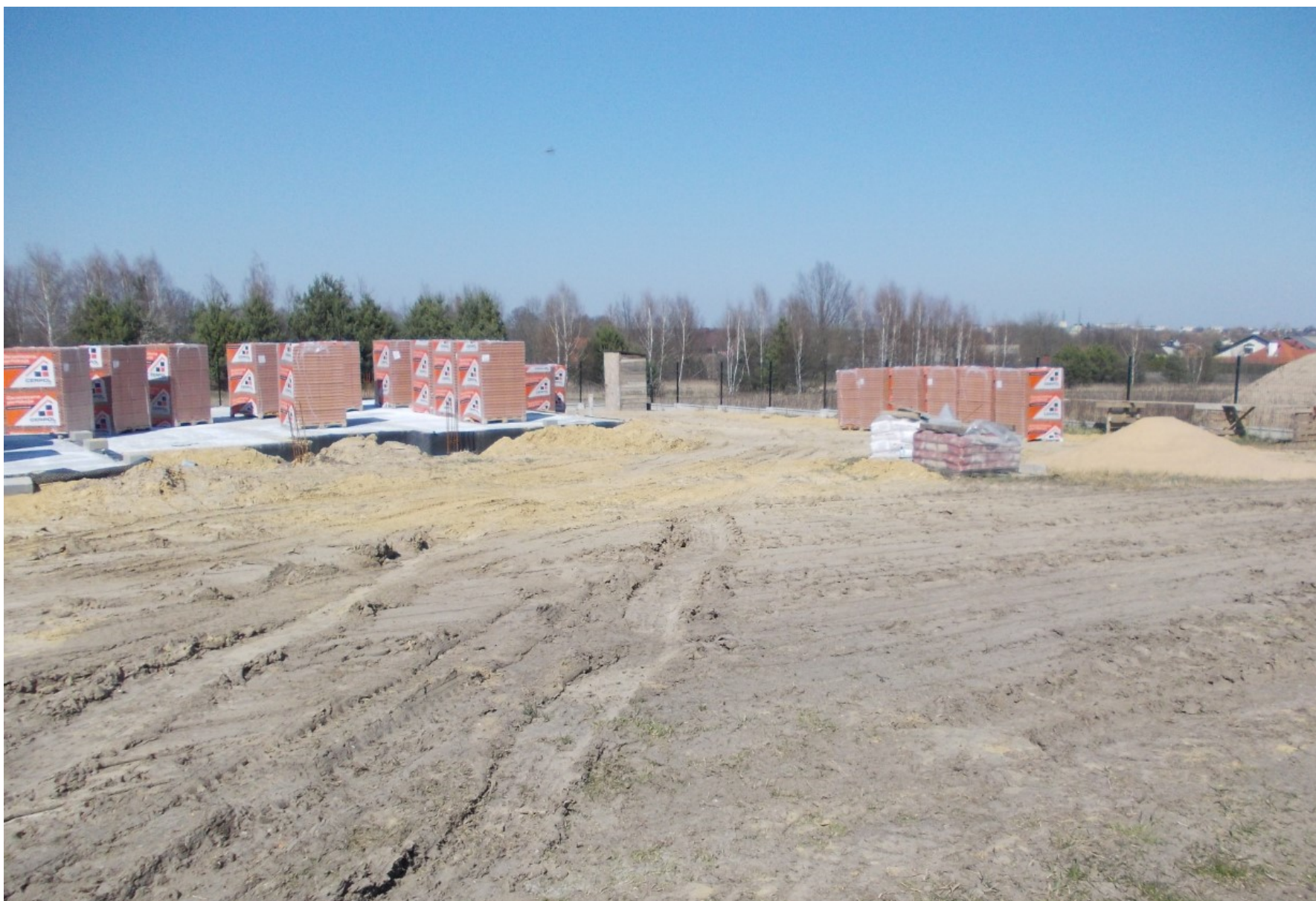
Zdjęcie nr 10 – ul. Mikołaja Reja („droga wewnętrzna” - ostatni budynek – w budowie – działka nr ew. 309/6)
