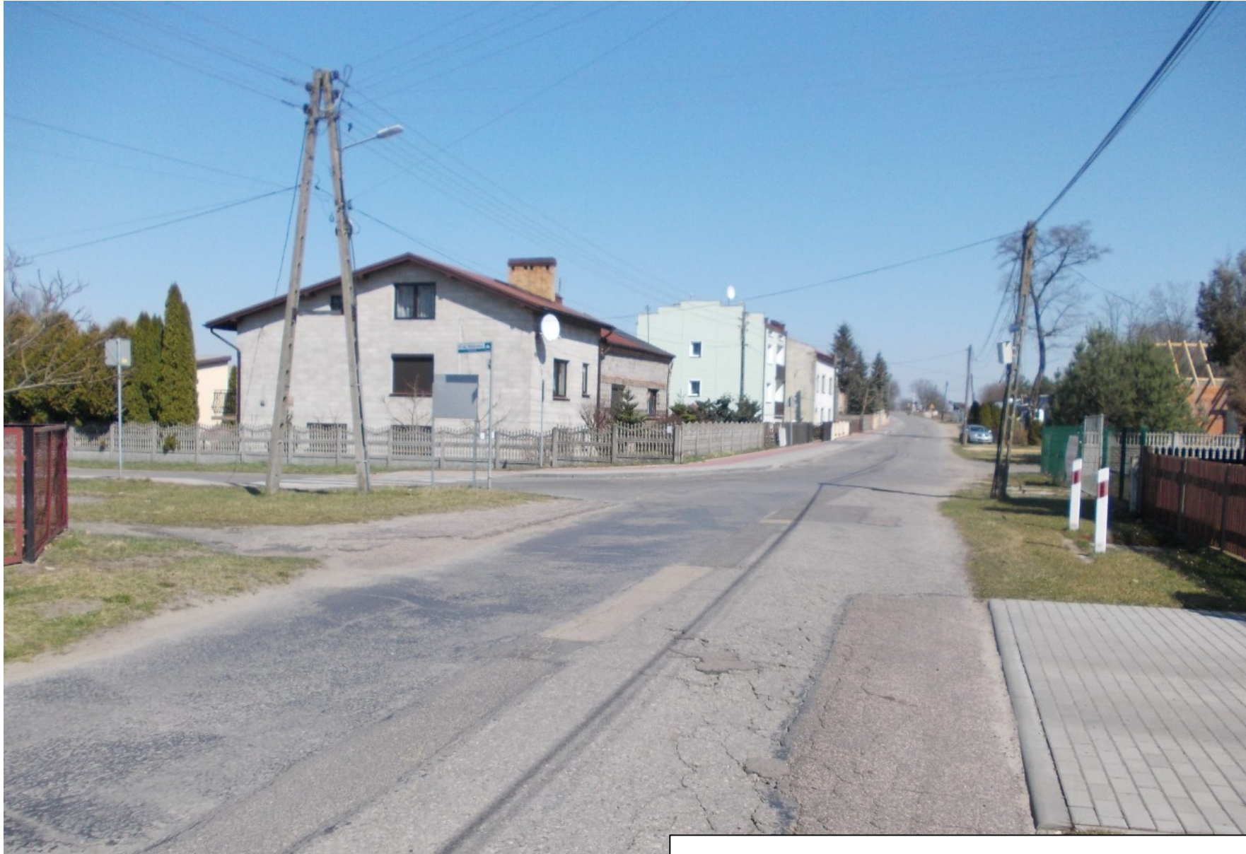
Zdjęcie nr 16 - ul. Zakrzewska przed skrzyżowaniem z ul. Stawową
