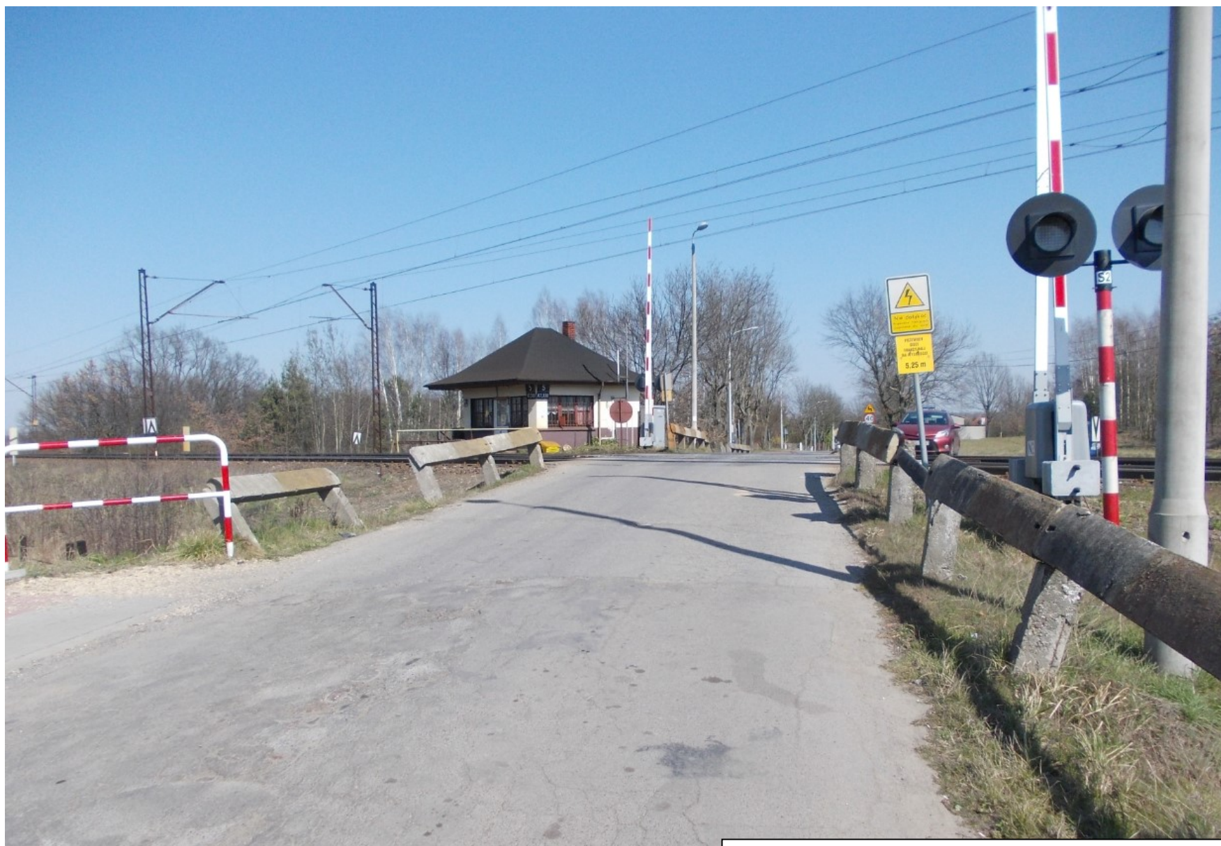
Zdjęcie nr 24 - ul. Zakrzewska - przejazd kolejowy
