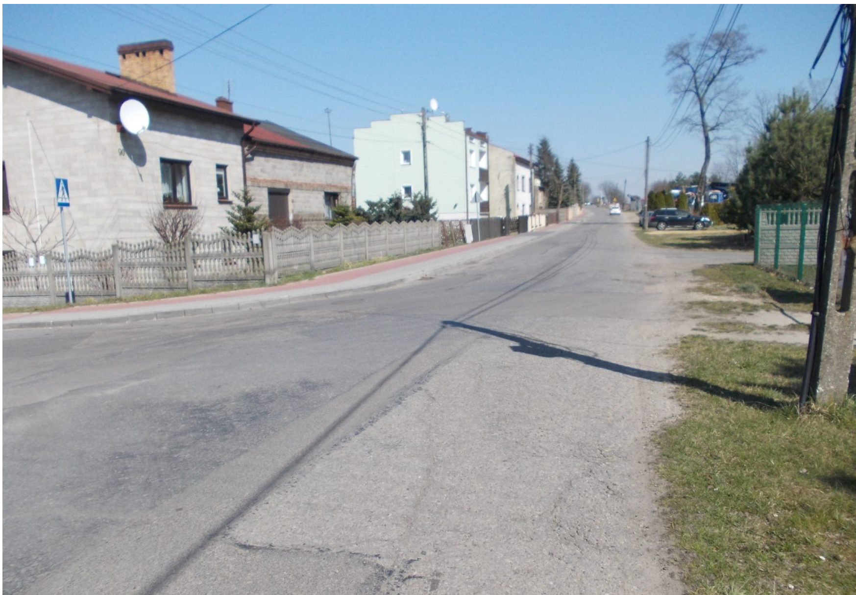
Zdjęcie nr 18 - ul. Zakrzewska za skrzyżowaniem z ul. Stawową
