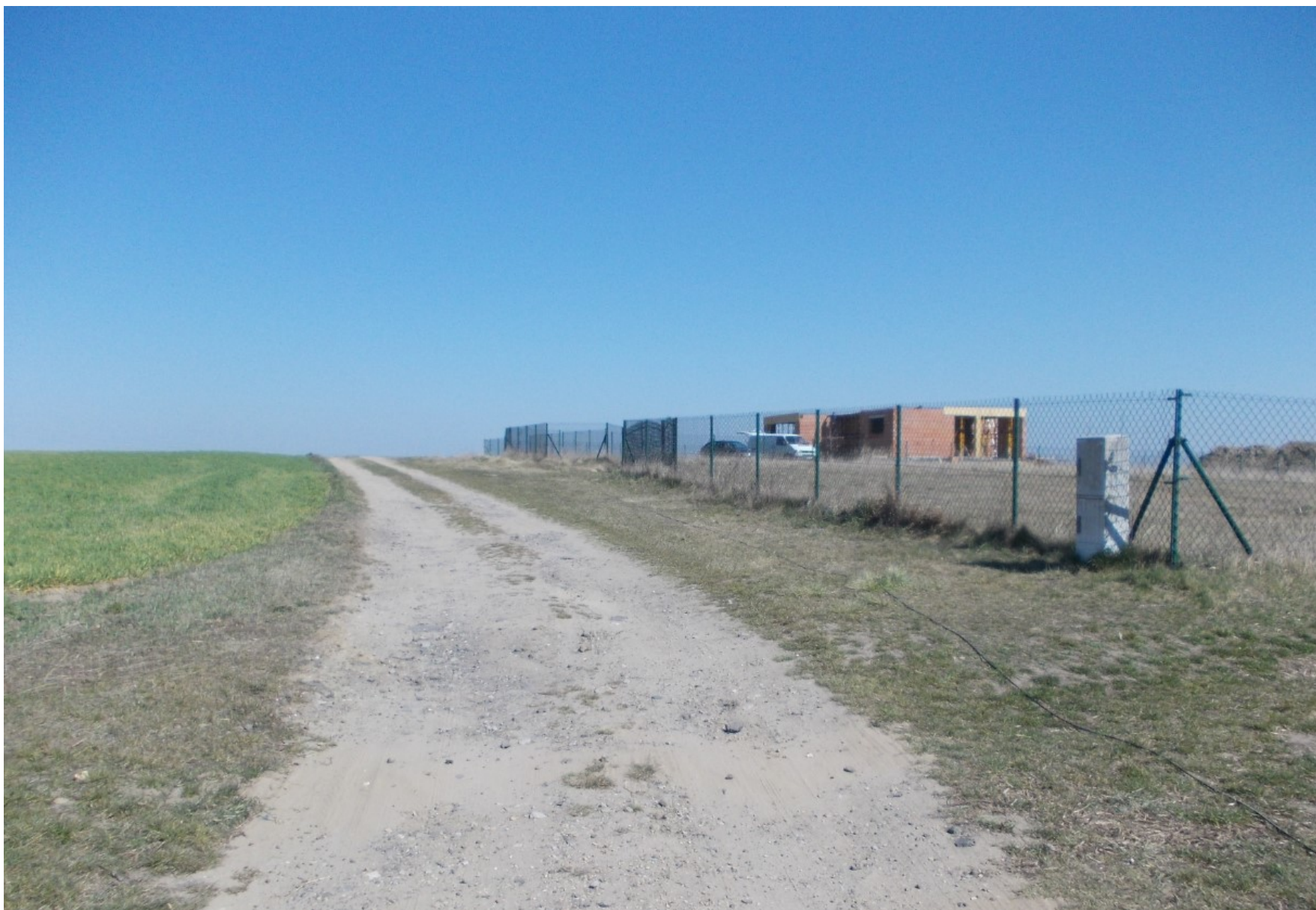
Zdjęcie nr 38 – ul. Kręta („zjazd na prawo” - dalszy ciąg) – ostatni budynek w ciągu ulicy.
