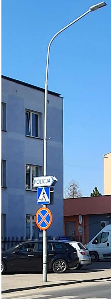
Rys1. Widok istniejącej latarni oświetleniowej z której należy zasilić projektowane latarnie doświetlające przejście dla pieszych
