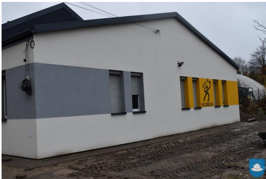
Termomodernizacja budynku zaplecza sanitarno-szatniowego OSiR w Kłobucku.
