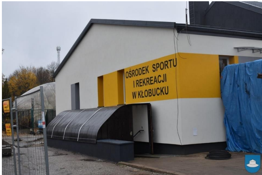
Termomodernizacja budynku zaplecza sanitarno-szatniowego OSiR w Kłobucku.
