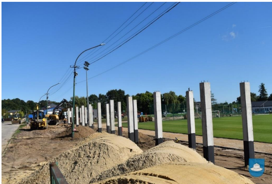
Trybuny na OSiR w trakcie realizacji.
