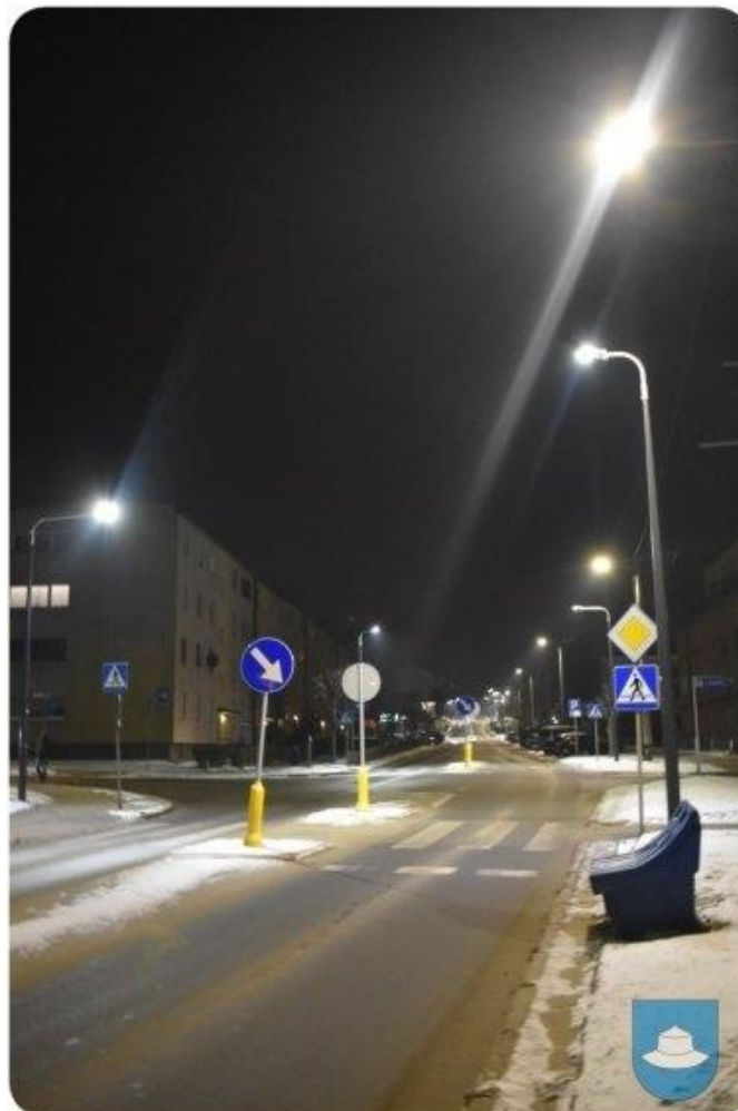
Doświetlenie przejść dla pieszych w ciągu ul. 11 Listopada.
