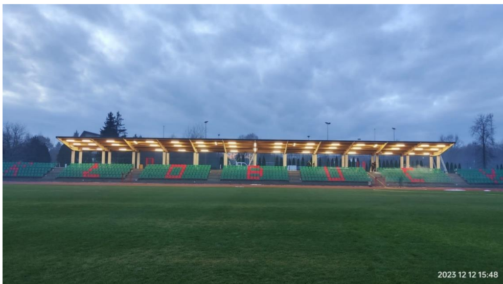
Trybuny na OSiR po realizacji.
