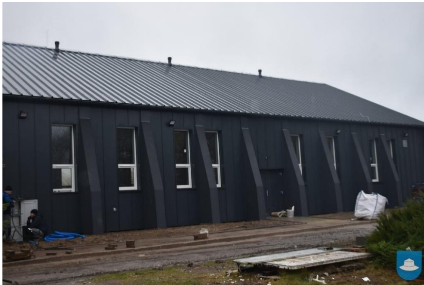
Termomodernizacja hali na terenie OSiR w Kłobucku.
