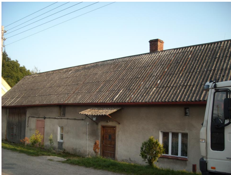
Fot. 6 Wykonane z płyt azbestowych pokrycie dachu w budynku mieszkalno-gospodarczym.
