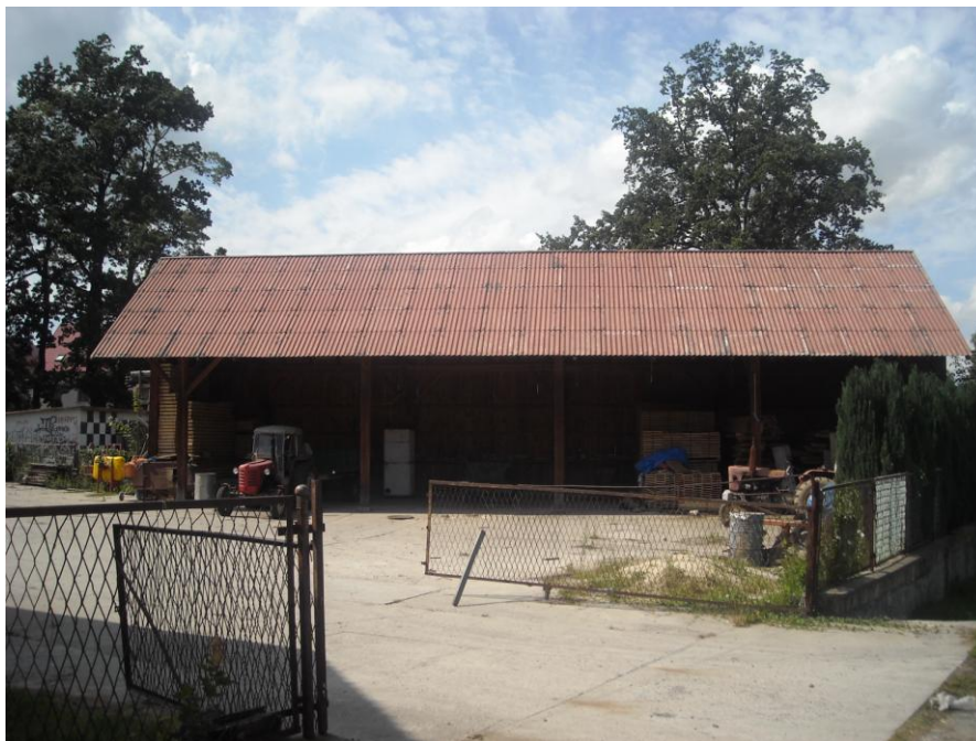
Fot. 2. Budynek gospodarczy pokryty malowanymi płytami azbestowo-cementowymi.
