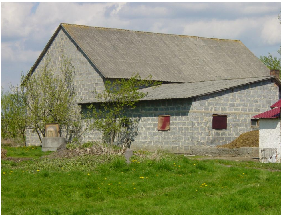
Fot. 7. Dachy, w tym zadaszenia azbestowe, o różnych spadkach. Budynek gospodarczy 45° i sąsiedni budynek gospodarczy 15°.
