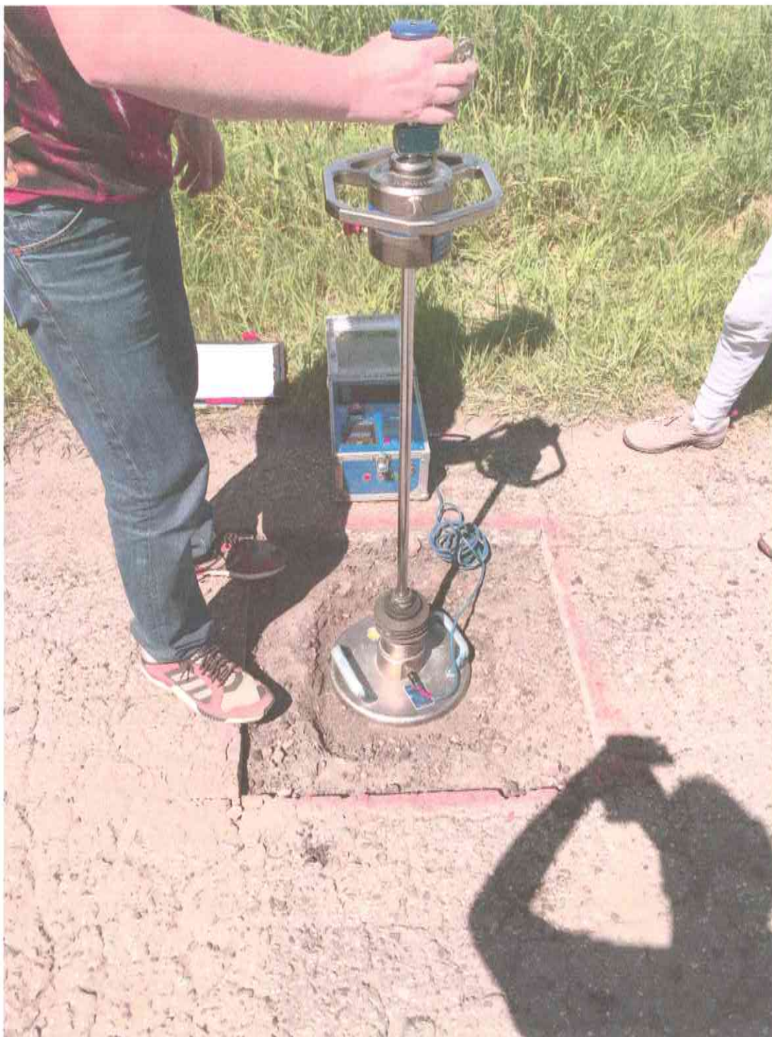
Rys. 7 Badanie nośności na wyciętej nawierzchni drogi
